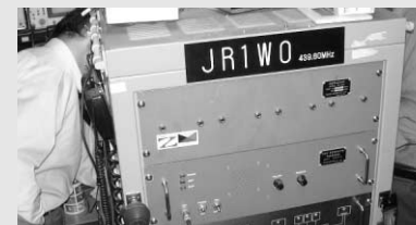
1段目がデュプレックス。2段目の両側に取っ手があるのがレピータ
