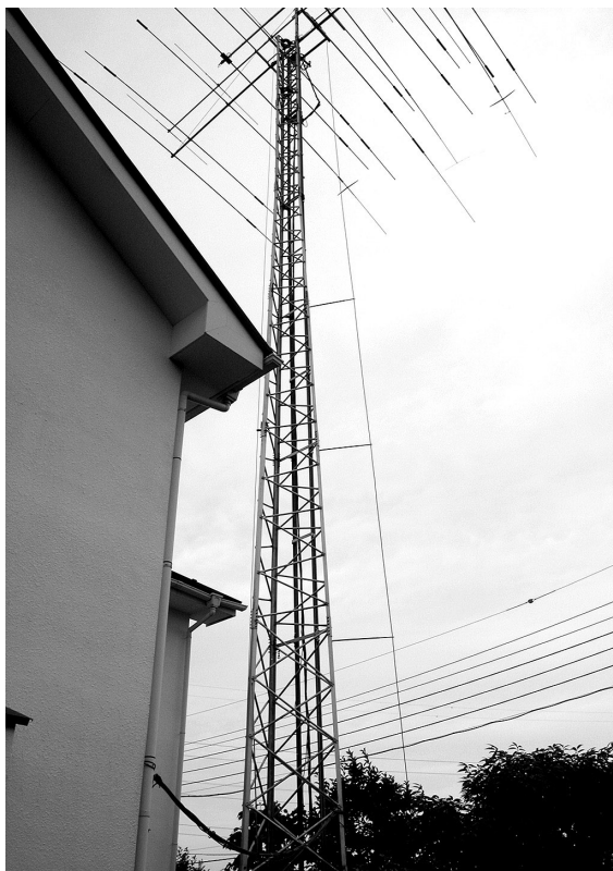
写真1 完成したシャント・フィード・アンテナ
