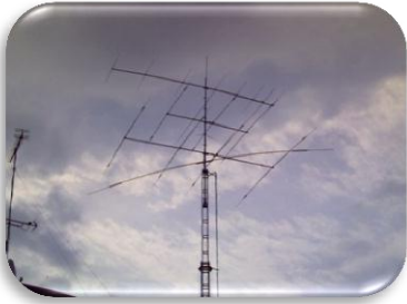
10MHzはNAGARAのTD-3040 (RDP) 24mH. 18/24MHzはクリエートデザインの248A (18MHz 3エレ/24MHz4エレ) 27mH Txn JN1NDY
