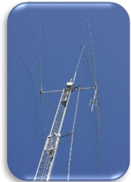
20mH 14~28MHz 5バンド 2エレメント・キュビカル クワッド. 10MHz用約9m長の垂直アンテナ+アンテ ナ・チューナ Txn JH3SIF
