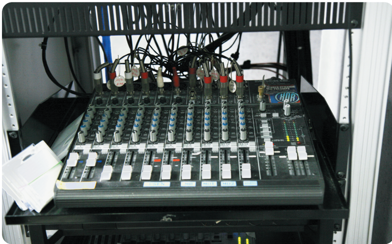
ラック中央下にあるミキサ(レインボータウンFM) ここにメイン・スタジオやサブ・スタジオ、そして中継先などの番組が集まってくる。
