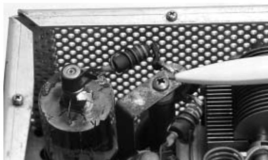
写真4-1 受信時にも+800Vは加えられている。カバーを外すとセーフティ・スイッチが作動して電源はOFFになる。しかし、セットによってはこのスイッチのないものもあるので要注意・危険！
