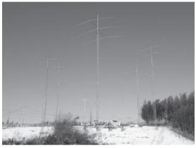
**6本のタワーに各バンドのYAGIアンテナがそびえる** (JR1AIB 井上OMのアンテナ・ファームの一部)
