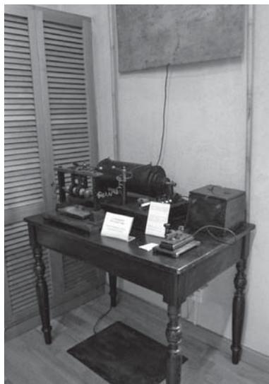
マルコーニはヘルツのダイポールを追試し、両端に付けた金属板の一つを地面（写真では机の下）に敷いて使った（マルコーニ博物館にて筆者撮影）
